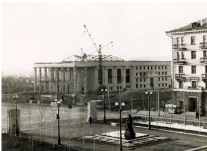
Строительство Белгородского областного драматического театра. 1954 г.
